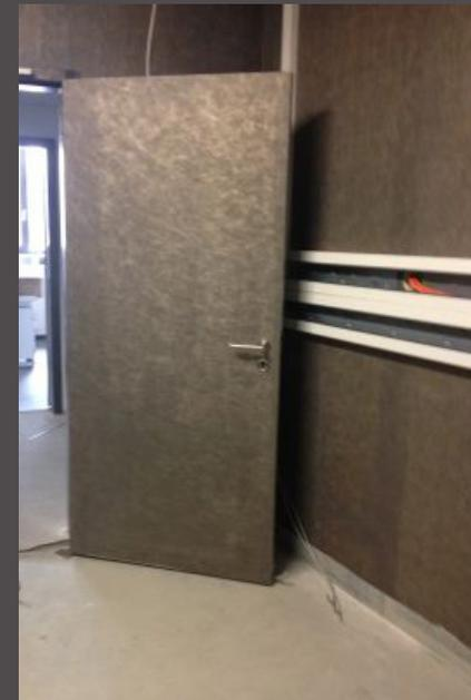
Durch die spezielle Struktur und Beschichtung ist das Schirmungssystem erstmalig neben dem elektrischen Feld auch für den magnetischen Bereich anzuwenden.
